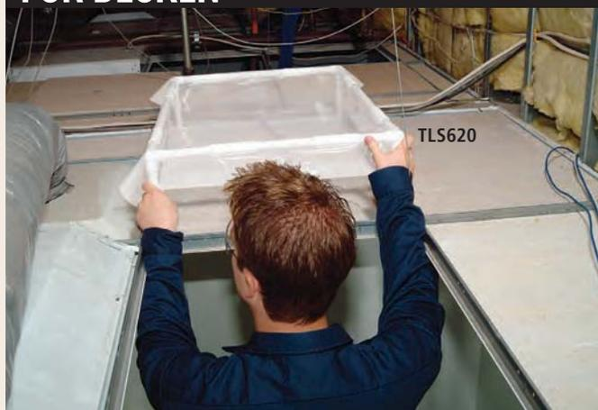
**PIG Decken-Leckage-Umleiter** lassen sich in Büroräumlichkeiten installieren und bieten unauffälligen Schutz.
